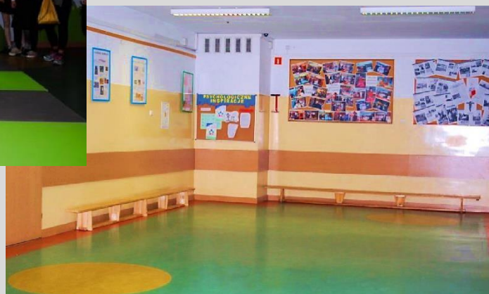
Przed remontem: wnęka jest mało przytulna i nijaka
