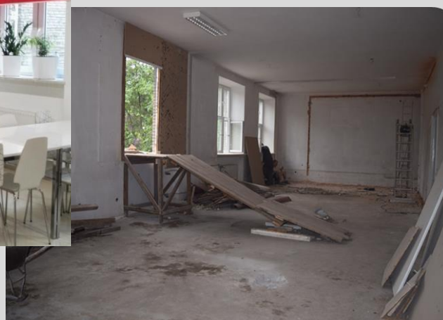
W trakcie remontu
