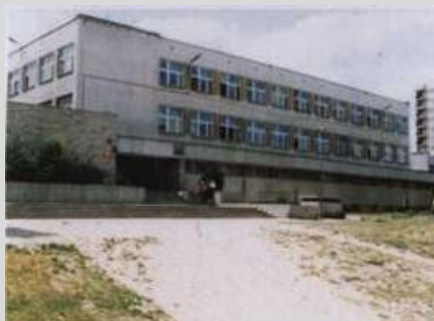
Budynek przed generalnym remontem, zaniedbana zieleni wokół szkoły
