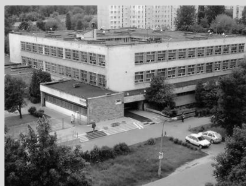
Szkoła przed remontem generalnym
