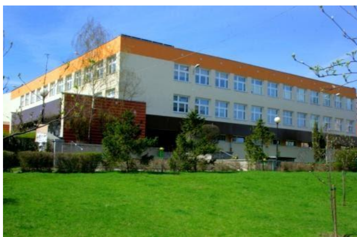
Obecna elewacja budynku
