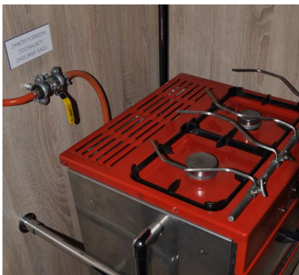
Fot.2. Kambuz. Kuchenka gazowa dwupalnikowa z piekarnikiem. Doprowadzenie gazu przez zawór pośredni odcinający
