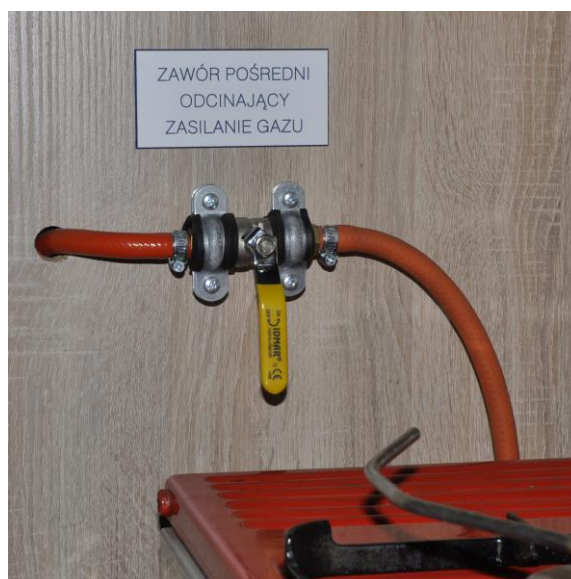
Fot.3. Kambuz. Zawór gazowy, pośredni, odcinający zasilanie gazu do kuchenki
