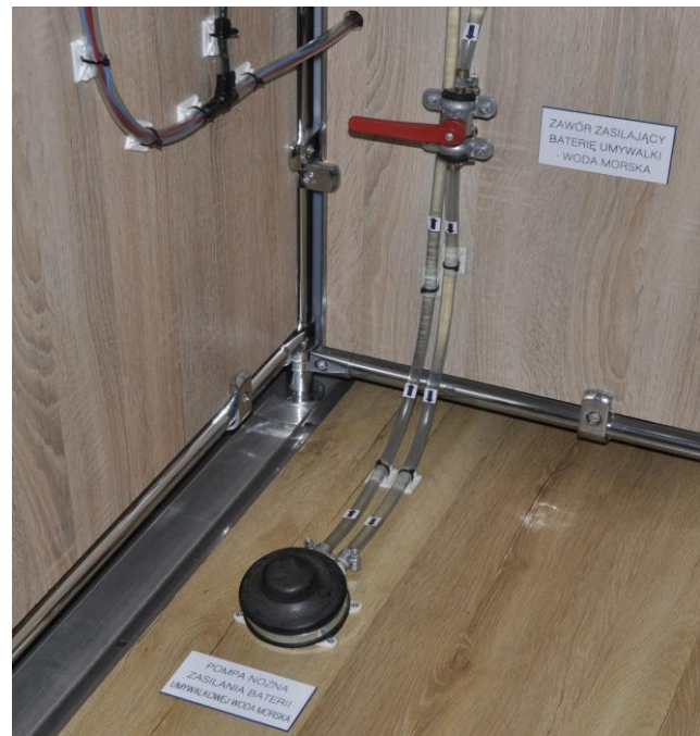
Fot.3. Pompa nożna zasilająca baterię zlewozmywaka w wodę zaburtową, zawór odcinający zasilanie baterii
