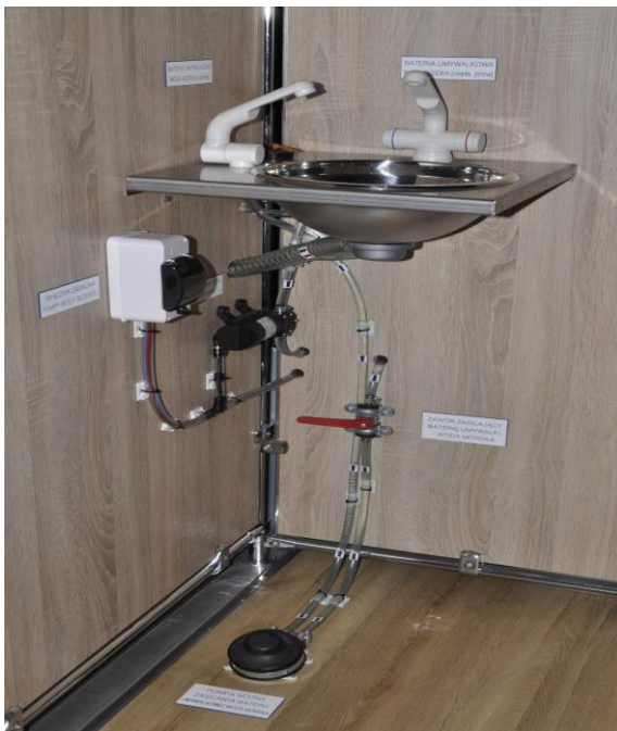
Fot.2. Nierdzewny zlewozmywak, baterie wodne, system zaworów i pomp
