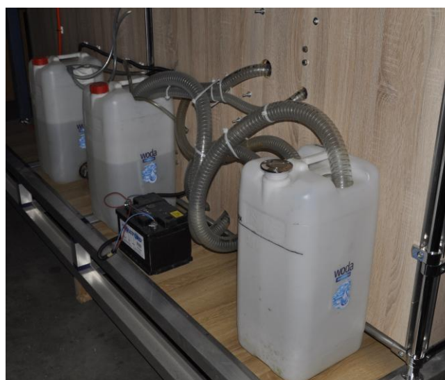
Fot.3. Na pierwszym planie magazynowy zbiornik fekaliów z WC
