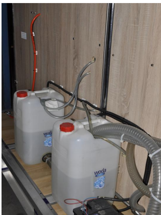
Fot.2. Na pierwszym planie zbiornik magazynowy fekaliów z umywalki kambuza i łazienki jachtowej
